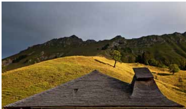
Schindeldach der Alphütte «Les Moilles» im Parc naturel régional Gruyère Pays-d'Enhaut..
